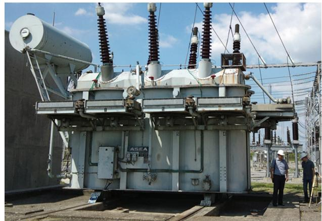
Djelatnici EMC laboratorija u postupku mjerjenja električnog i magnetskog polja transformatora
